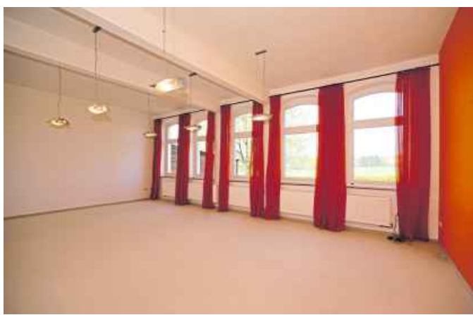
Im ehemaligen Klassenzimmer wurden jahrelang Yogakurse und Klangmeditation angeboten. Jetzt entsteht hier Wohnraum.
